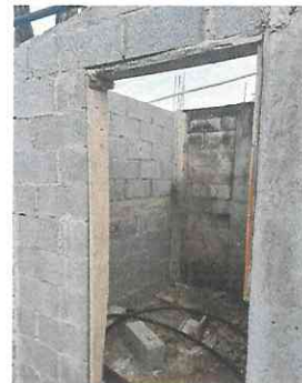
Implementacion de muro de block para baño de niños, lamina en techo de baño y cernido de paredes
