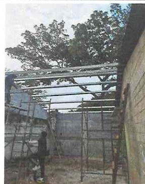
Techado en parte trasera del establecimiento
