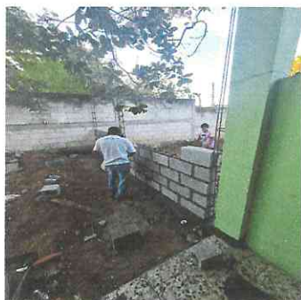
SUSTITUCION DE MURO PERIMETRAL
